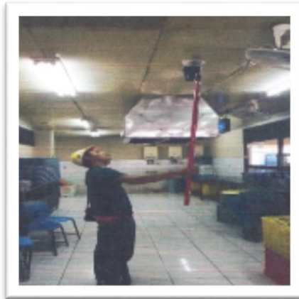
Gambar 4.15 Pengetesan detector Sumber: Dokumen PT X
